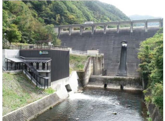
水力発電所の新規建設を推進（横川蛇石発電所）
