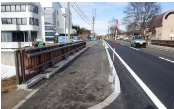
ランニングコースとして使用する歩道の整備（菅平高原）
