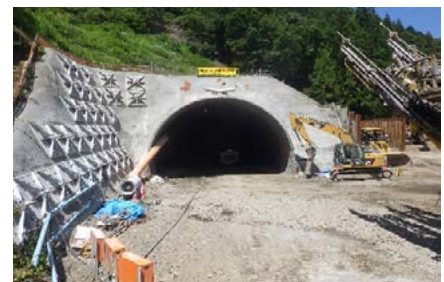
国道158号狸平トンネル工事（松本市）
