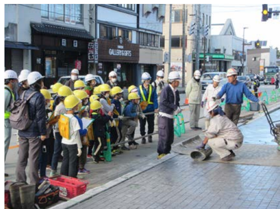
白馬駅無電柱化工事の現場を見学する小学生（白馬村）
