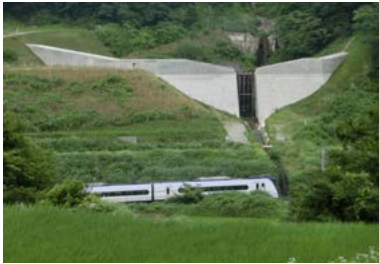
砂防堰堤（小谷村）
