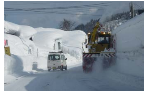
国道117号の除雪作業
