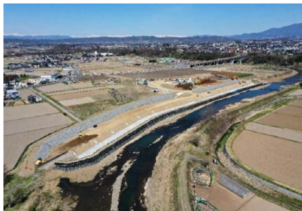
堤防・護岸整備による治水安全度の向上
