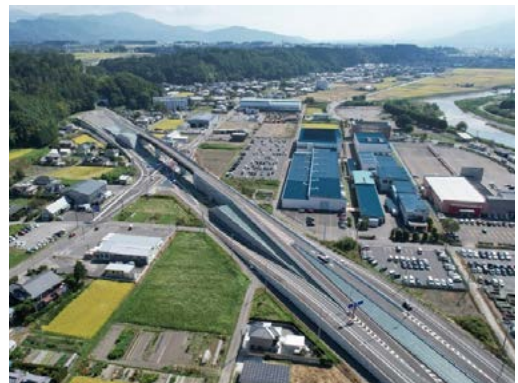
国道153号伊那バイパス
