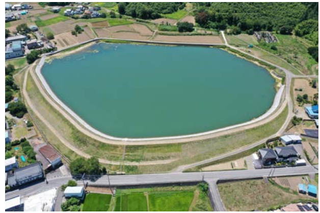
耐震化工事を実施した防災重点農業用ため池
